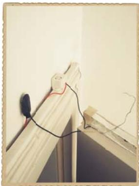
Теперь установите зуммер и контактный провод над дверным проемом. Сначала клейкой лентой прикрепите контактный провод к притолоке двери таким образом, чтобы, когда дверь закрыта, он свисал перед дверью, а при ее открывании ложился на полоску фольги.
